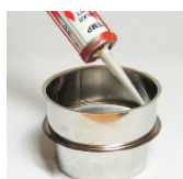
Tätning med pannkitt vid anslutning.
