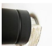
Isolera noggrant runt kopplingsstycket.
